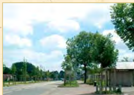
Réalisation d'un projet de traverse d'agglomération
