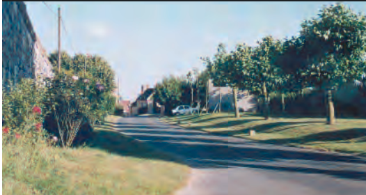
Tronçon ne desservant pas d'habitation ; caractère rural affirmé des vastes trottoirs engazonnés.
