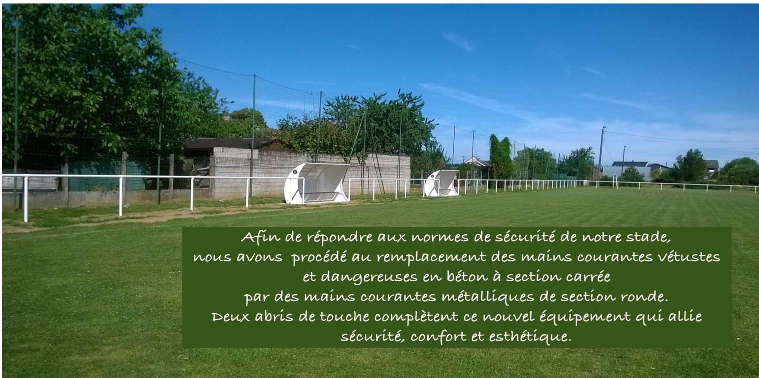
*Afin de répondre aux normes de sécurité de notre stade, nous avons procédé au remplacement des mains courantes vétustes et dangereuses en béton à section carrée par des mains courantes métalliques de section ronde. Deux abris de touche complètent ce nouvel équipement qui allie sécurité, confort et esthétique.*
